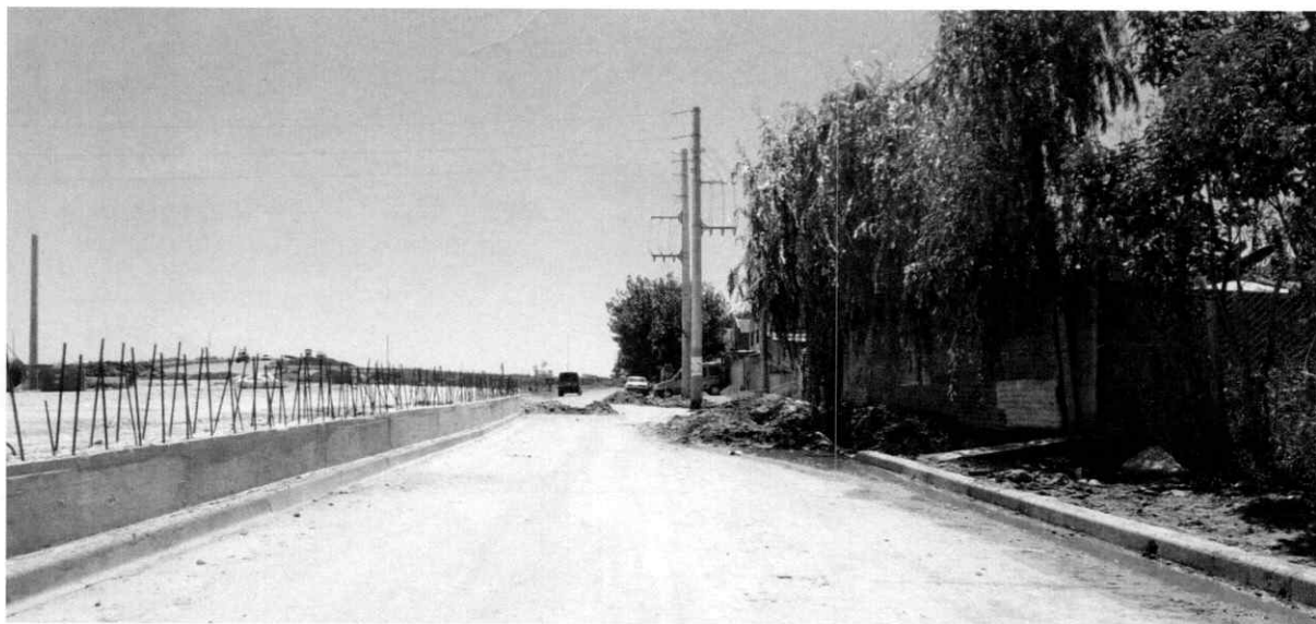
Registro fotográfico de la obra en ejecución obtenido desde av. 520, enfocando hacia la AU. Obsérvese la proximidad crítica entre calzada-cordón cuneta y el frente de viviendas.
