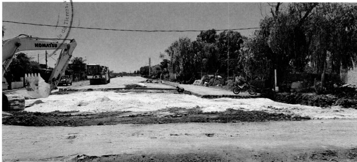
Registro fotográfico de la obra en ejecución obtenido desde calle 119, enfocando hacia la AU.
