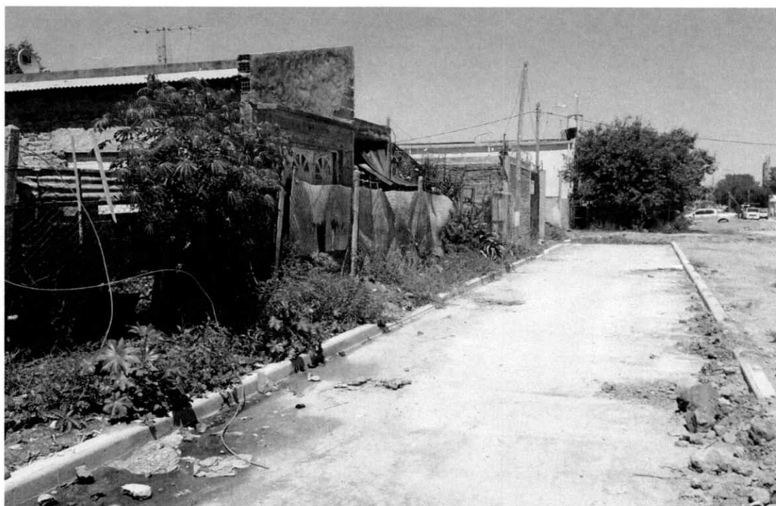
Registro fotográfico de la obra en ejecución obtenido desde av. 520, enfocando hacia la calle 118. Obsérvese la proximidad crítica entre calzada-cordón cuneta y el frente de viviendas.
